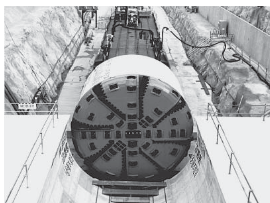
TBM（トンネルボーリングマシン）
