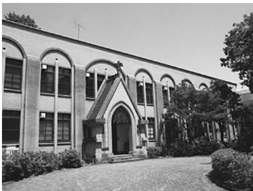
写真-2 東京大学教養学部101号館
