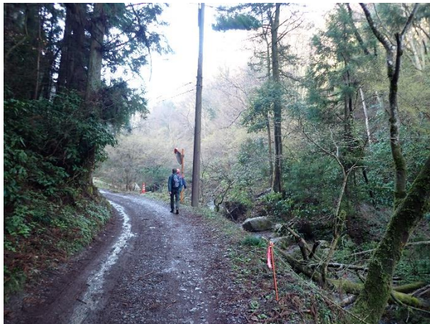
林道(沢浴い)に NTT 電柱
